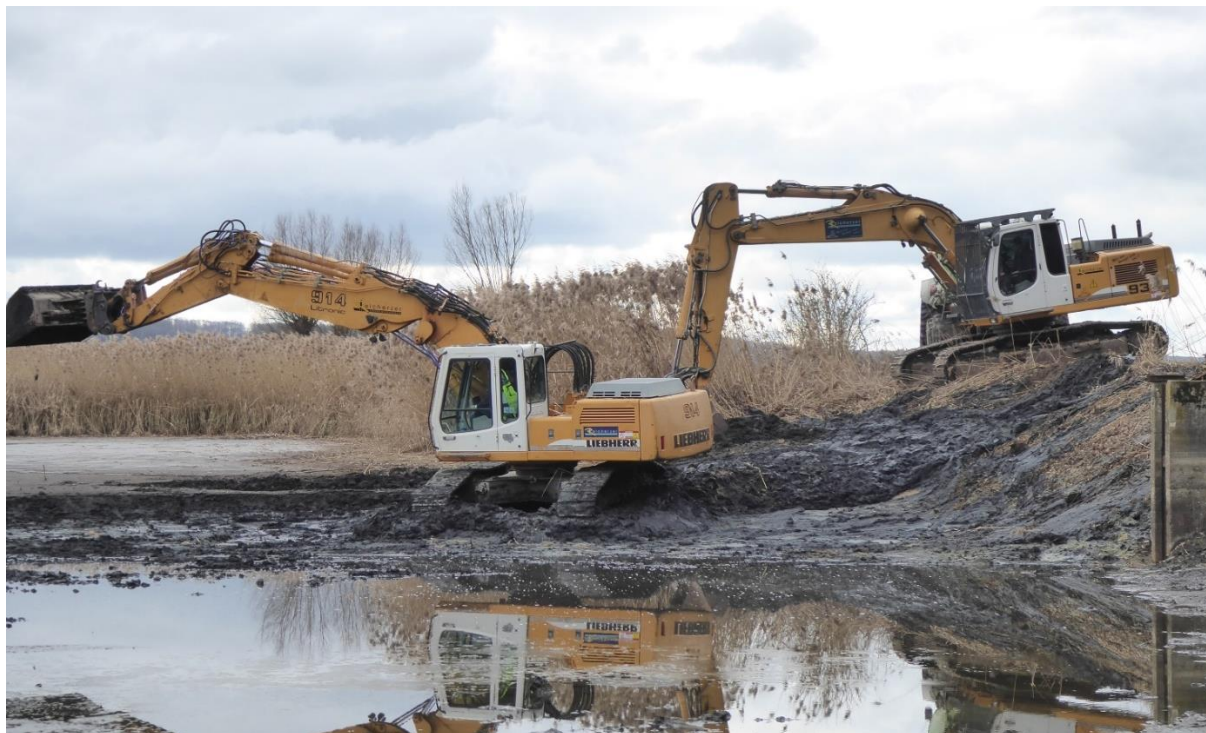
Schlammmentnahme aus dem Anhauser Weiher im März 2023,
